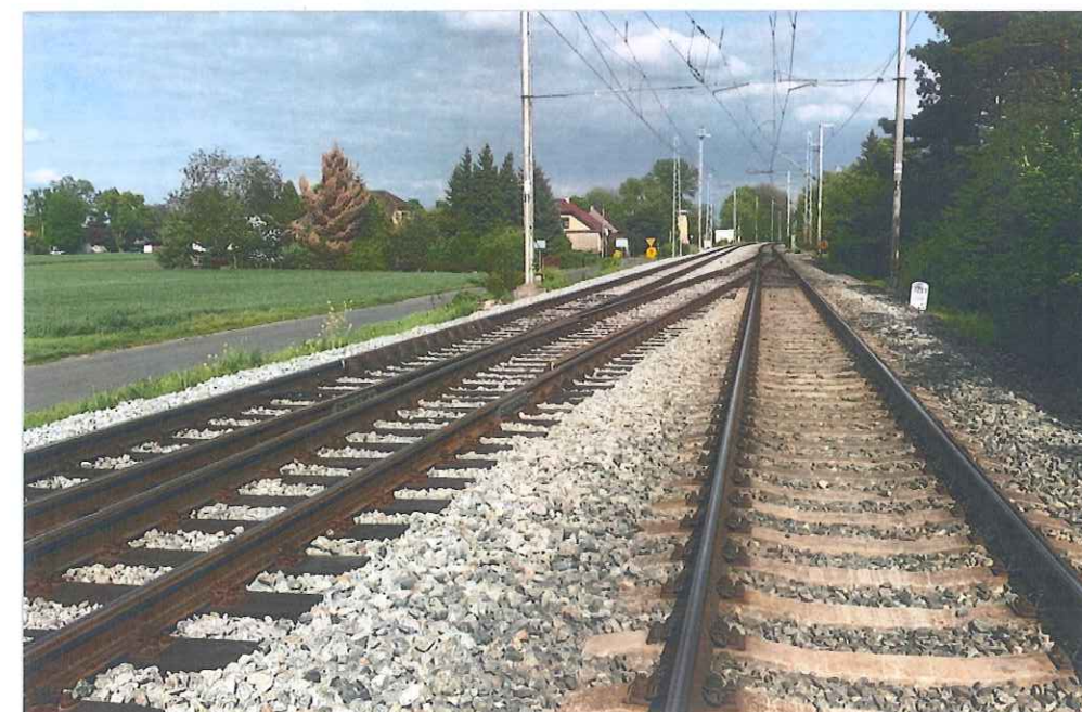
Úsek železniční trati v místě měření
